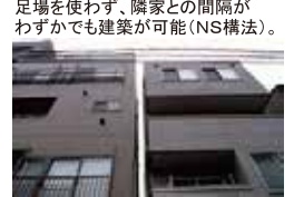
足場を使わず、隣家との間隔がわずかでも建築が可能 (NS構法)。
