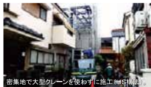
密集地で大型クレーンを使わずに施工(HS構法)。
