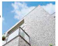
太陽の光で汚れを浮かせ、雨が降ると洗い落ちる光触媒タイル。
