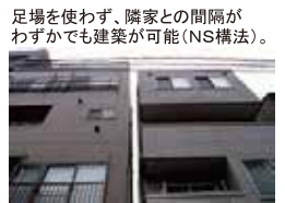
足場がなければ、その分大きな建物が建てられます。
