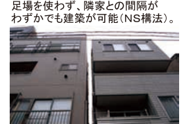
足場がなければ、その分大きな建物が建てられます。
