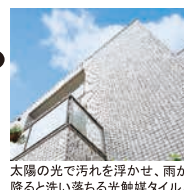
太陽の光で汚れを浮かせ、雨が降ると洗い落ちる光触媒タイル。
