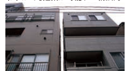
足場を使わず、隣家との間隔がわずかでも建築が可能(NS構法)。
