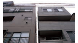
足場を使わず、隣家との間隔がわずかでも建築が可能(NS構法)。
