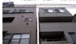
足場を使わず、隣家との間隔がわずかでも建築が可能(NS構法)。
